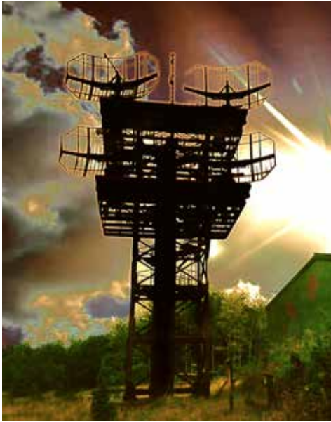
Hornstrahler auf Antennenträger
