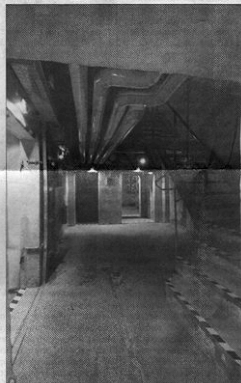
2004 begann Wenzel mit dem Auspumpen des Bunkers.
